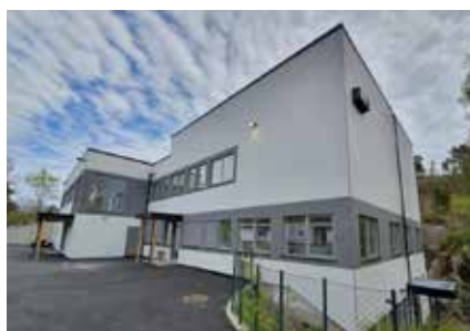
Menighetshusets fasade mot sørvest
